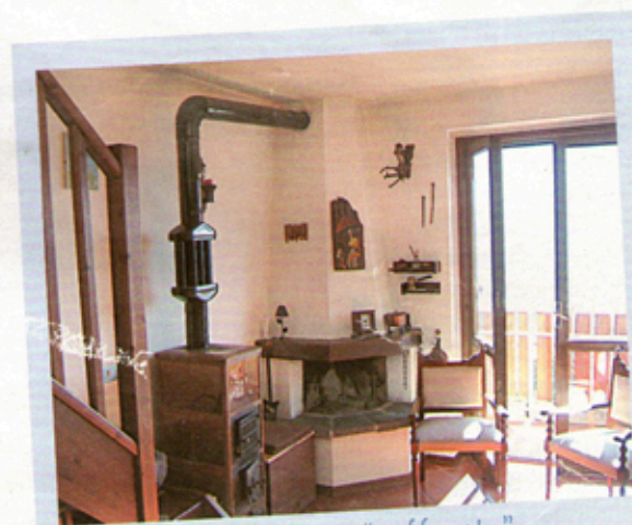
Prima: il camino era "soffocato" dalla stufa, inutile dato che esisteva già l'impianto di riscaldamento
